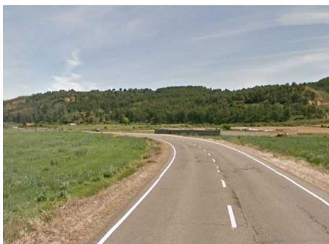
Figura 53. Detalle de la LE-5508 al inicio del trazado. Fuente: Elaboración propia
