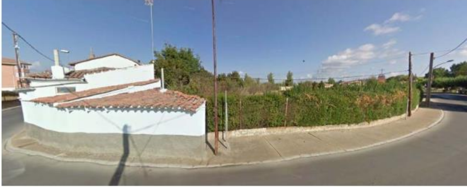
FOTOGRAFÍA 3. Vista de la CALLE REAL desde la Calle Galicia
